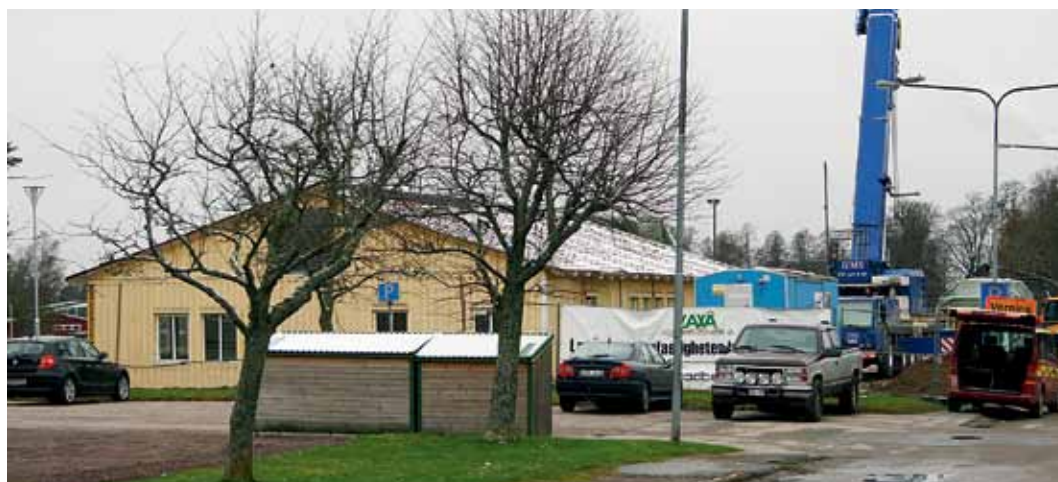
Skolmodulerna är på plats i Laxå. Nu pågår arbeten till i maj 2015 då den nya skolan kan tas i bruk.
