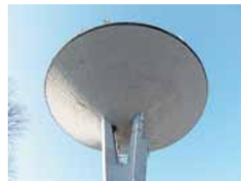
50-årigt vattentorn renoveras nu. Foto: Per Molin
