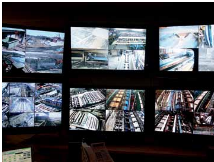
Hela tillverkningsprocessen kameraövervakas från ett kontrollrum.
