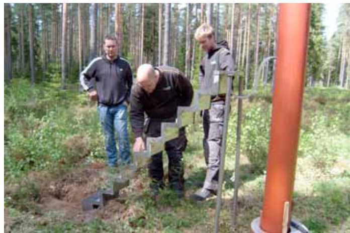
Per Molin VA-tekniker, Anders Eriksson, reparatör, och Mikael Karlsson, VA-tekniker startar pilotprojektet i slutet av maj. Nu är anläggningen i kontinuerlig drift.
