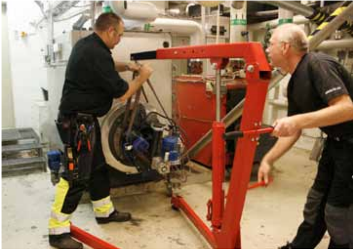
Dags för vinterbrännare! Fastighetsskötaren Gerhard Weerman och driftsansvarige Ola Larsson tar bort sommarbrännaren för att ersätta den med en kraftigare brännare som klarar vinterns köldknäppar.
